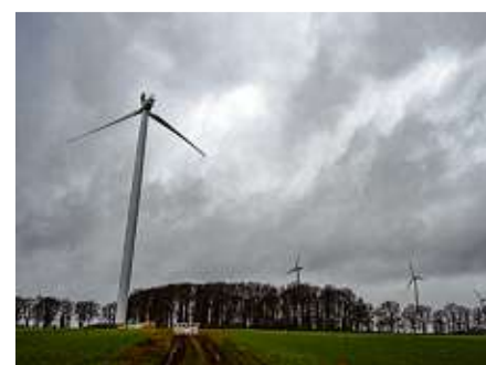
Da fehlt doch was: das beschädigte Windrad bei Uelzen. FOTO: P. SCHULZE/DPA
